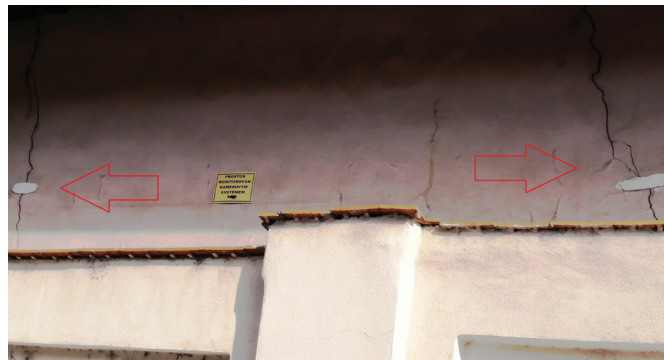
Obr. 2. Ukázka aplikace mikrometrického snímače – sádrové indikační pásky.
