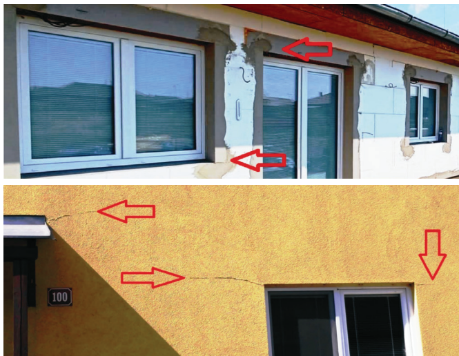
Obr. 4. Technologická nekázeň – vynechání technologických detailů při montáži armovací tkaniny vede k trhlinám, prasklinám na finální fasádní omítce.
