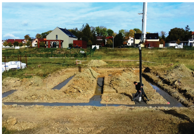
Obr. 3: Betonáž základové konstrukce do předem připraveného výkopu.
