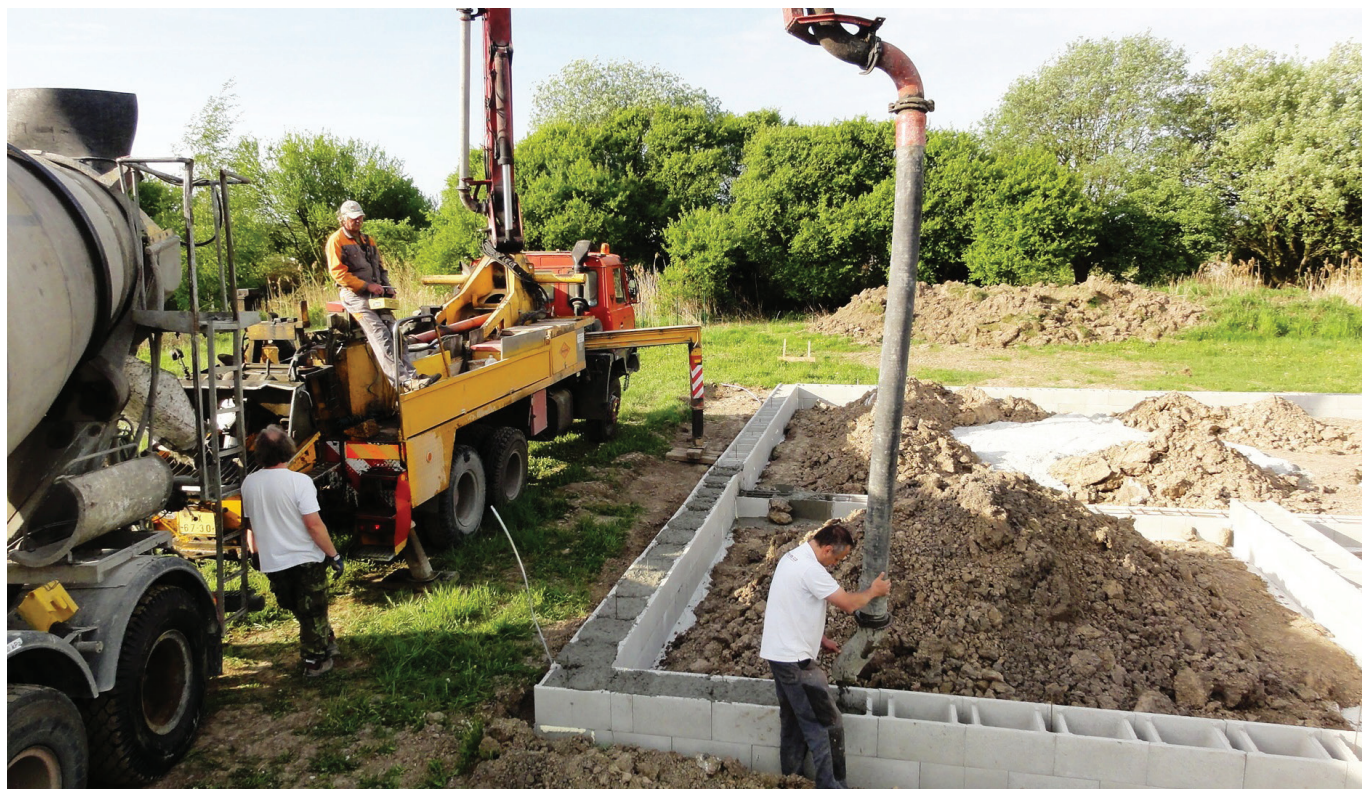
Obr. 4: Betonáž betonových tvárnic ztraceného bednění.
