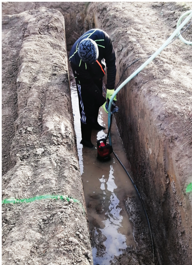
Obr. 2: Před betonáží je vždy nutné vodu odčerpát a ručně nebo strojně odtěžit promáčenou zeminu.
